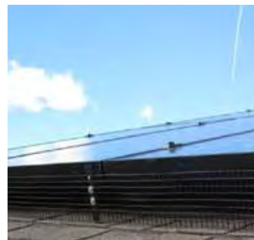
Fig 12.2 - Array Edge Screen Installed
